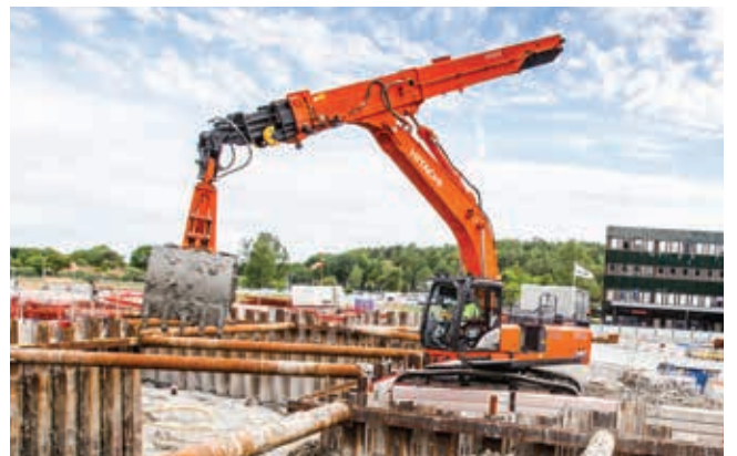
Excavadoras para aplicaciones especiales
