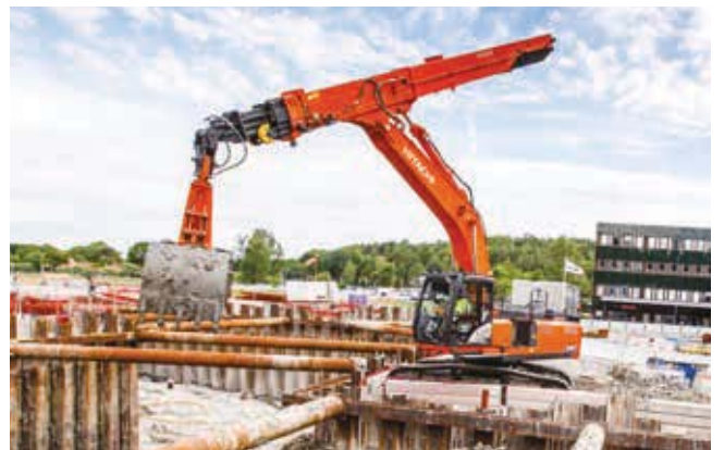
Excavadoras para aplicaciones especiales
